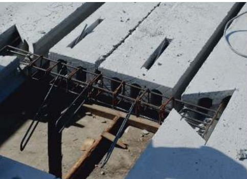
Zamontowanie zbrojenia wymianu w kanałach płyt.
